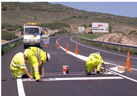
Pavimentacion de Pistas
